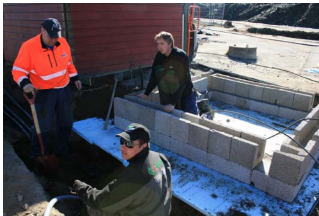
Nytt overbygg til pumpe-stasjon
