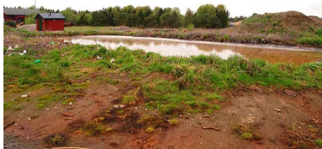
Figur 8. Infiltrasjon av sigevann
