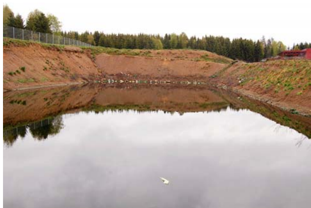
Figur 7. Prøvetakingspunkt infiltrasjonsbasseng (infiltrasjon i grunnen)
