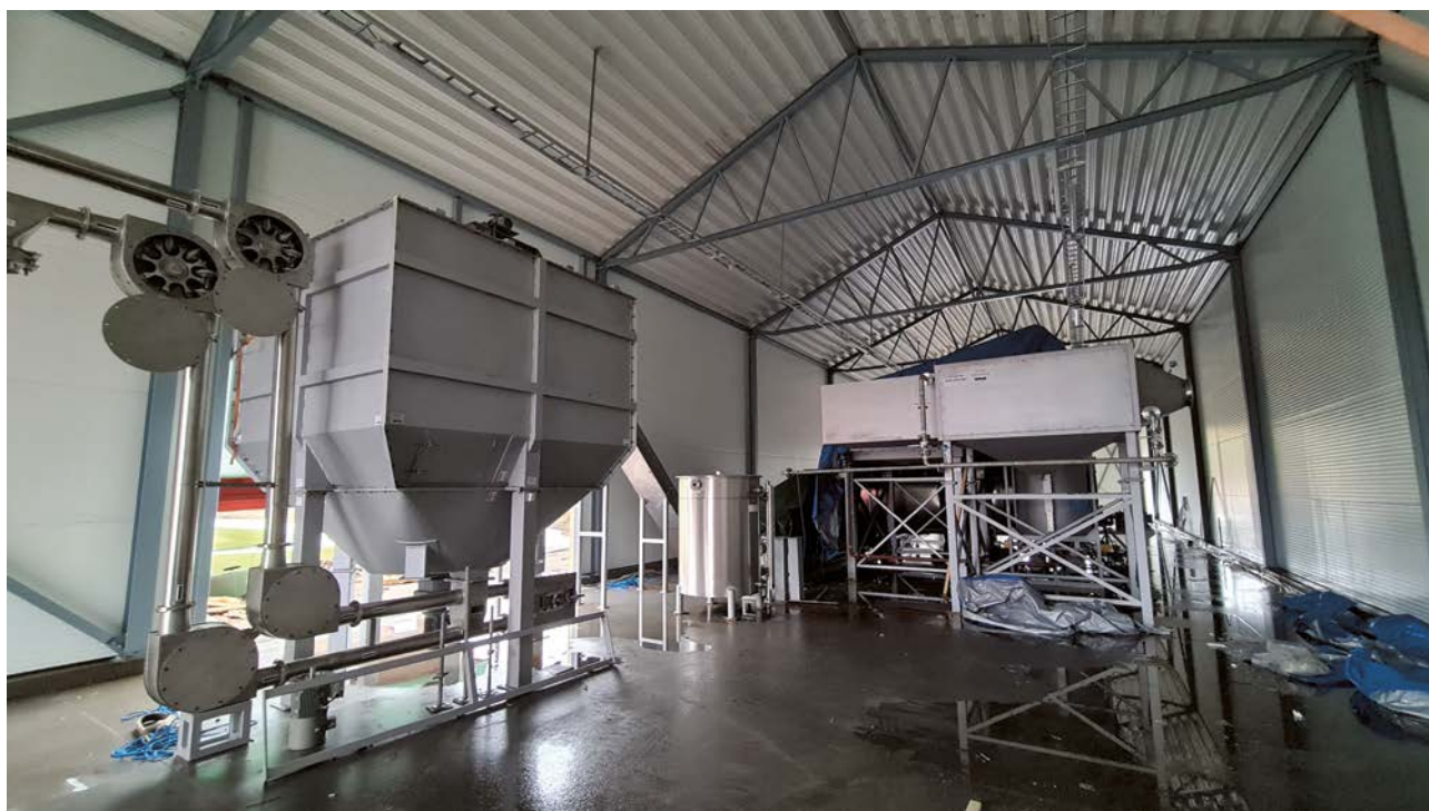
Pyrolyseanlegget under oppføring. Foto: ØRAS
