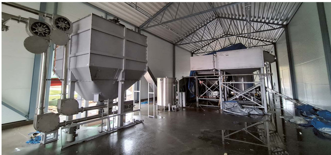
Pyrolyseanlegget under oppføring. Foto: ØRAS
