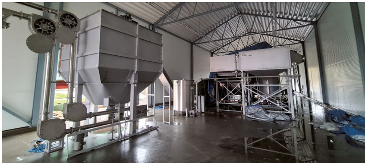
Pyrolyseanlegget under oppføring. Foto: ØRAS
