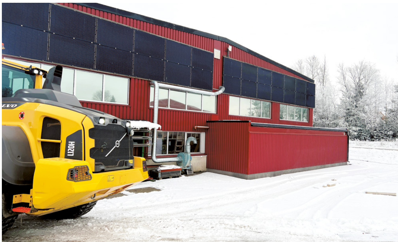
Kreativt gjenbruk: Verkstedet ble i 2024 utvidet med lagerplass med en ombrukskontainer. Foto: ØRAS
