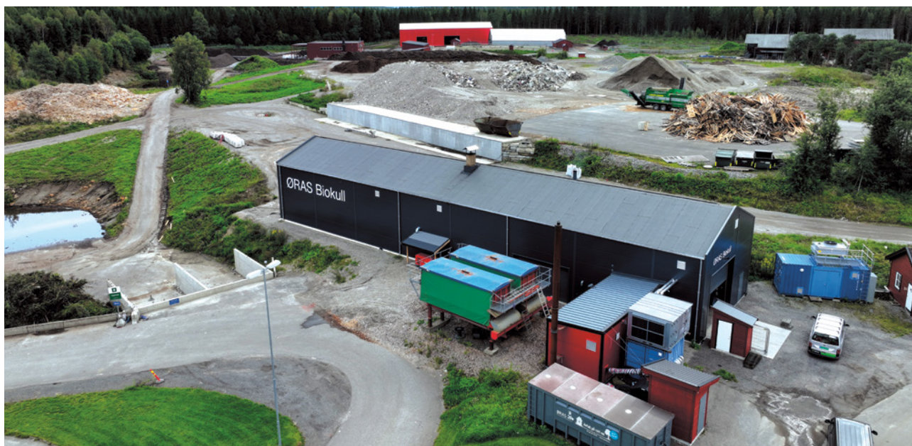
ØRAS sitt pyrolyseanlegg ligger inne på Miljøstasjonen. Foto: ØRAS
