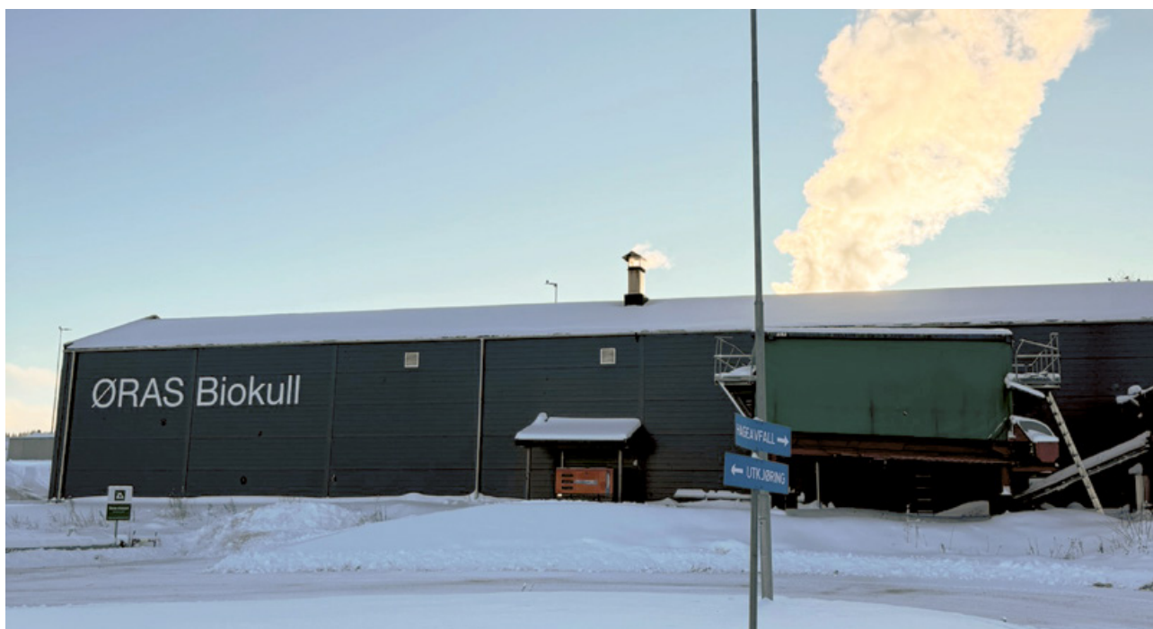
ØRAS sitt pyrolyseanlegg ligger inne på Miljøstasjonen. Foto: ØRAS
